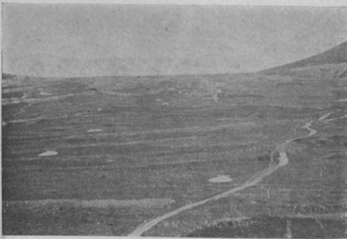
Abb. 39. Vizinalbahn Alvincz-Nagyszeben, Wasserscheide Szelistye-Ecsellő. Aufgelassene gerutschte Landstraße. Sondierbohrlöcher.
