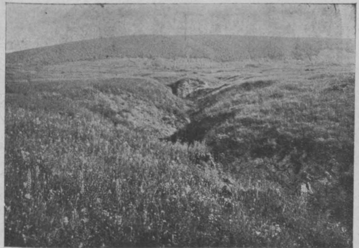
Abb. 40. Vizinalbahn Alvincz-Nagyszeben, Wasserscheide Szelistye-Ecsellő. Verlegte neue Landstraße (oben). Ansicht des tiefen Grabens in der Bahnachse (unten).
